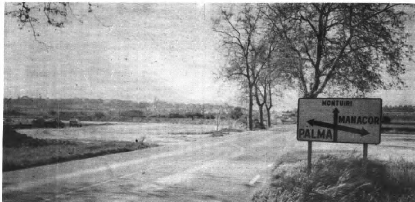
Explanación de terrenos junto al cruce de las carreteras Palma-Manacor y Montuiri-Porreres.
