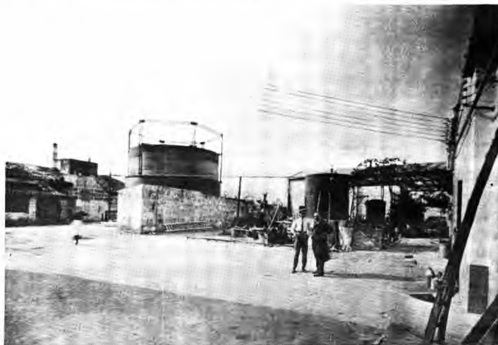
Los depósitos de gas.
