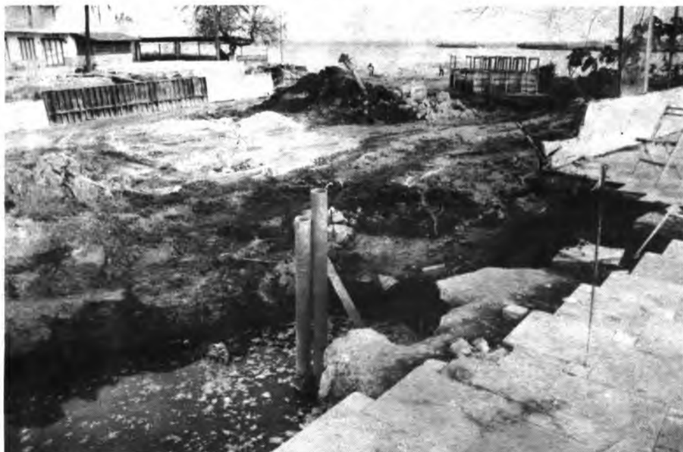
Las obras del Riuet de S'Illot, esta misma semana. Foto: Quick
