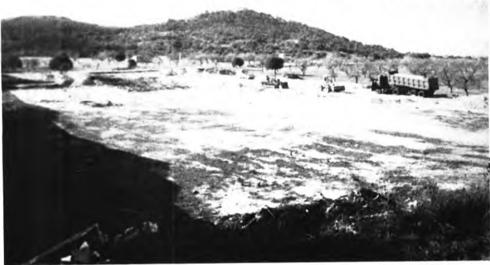
A finales de Diciembre de 1.988 se inicia la nivelación y compactación de los terrenos.
