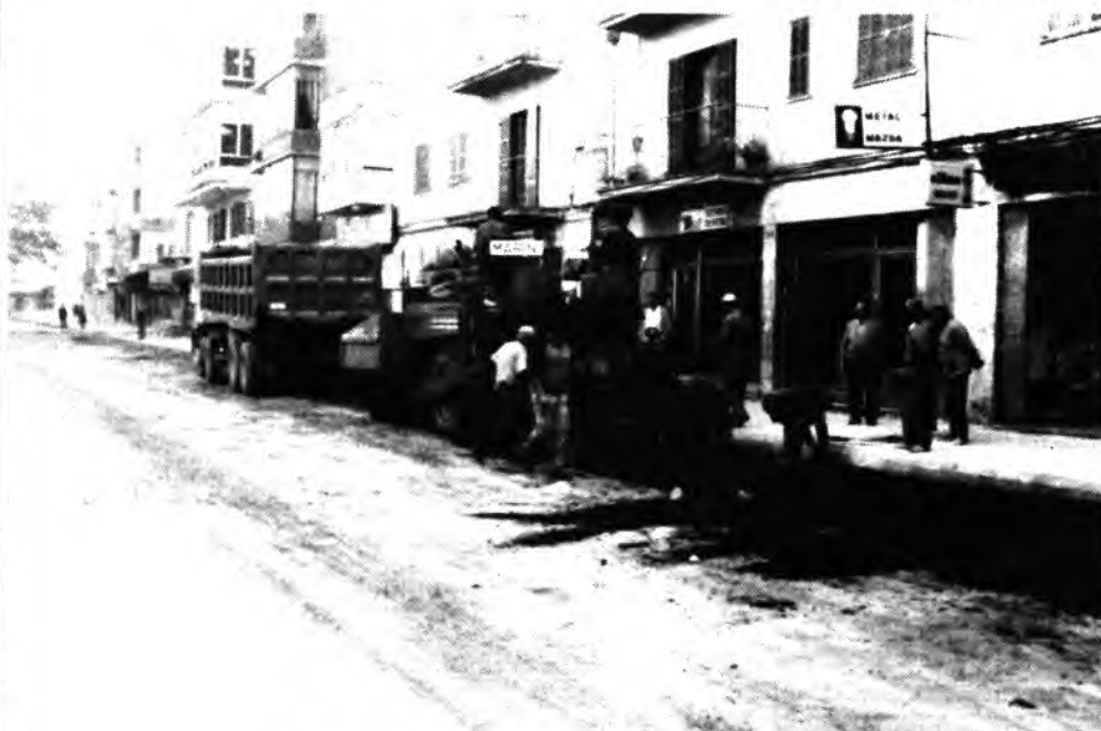
La brigada del asfalto iniciando su trabajo.
