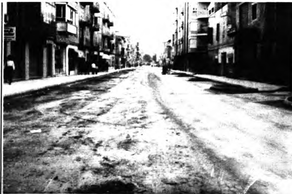
Es Torrent, recién asfaltado, todavía sin tránsito rodado.
