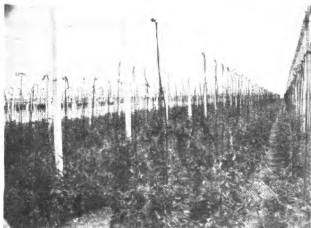
Vista interior de vigas pretensadas con cultivo intensivo de tomate.
