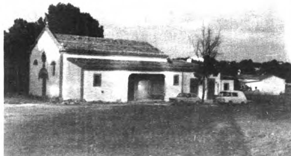
Este es el edificio conocido con el nombre de "Escola del Puig de l'Anar," de propiedad municipal, en el que se están realizando obras de acondicionamiento al objeto de que pueda utilizarse para sus actos la Asociación de Vecinos de la zona.
