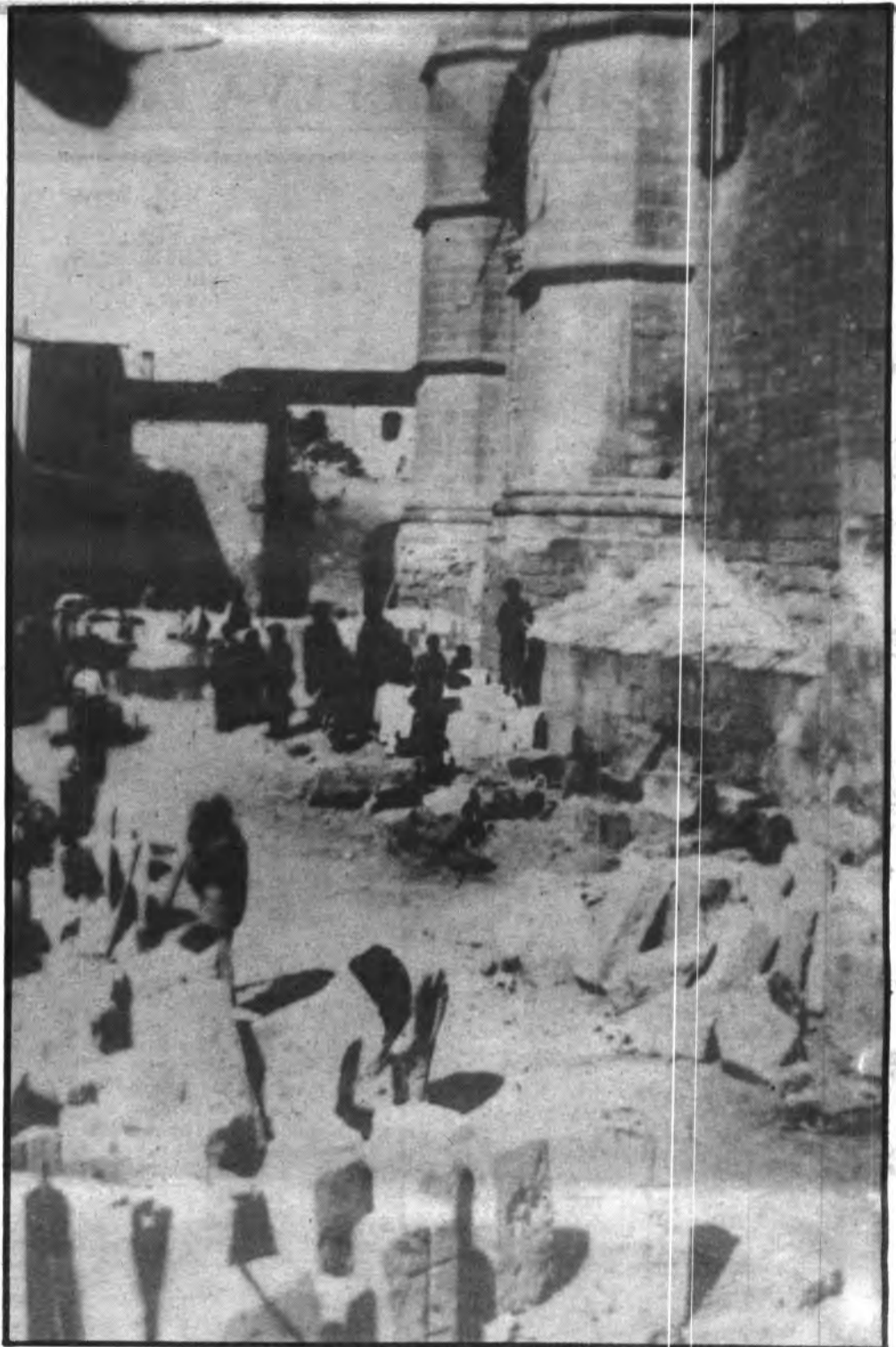
Esta vieja imagen corresponde, con toda probabilidad, a principios de 1906. Pueden verse los primeros sillares del futuro campanario alinearse entre los dos torreones del templo antiguo. Y en el torreón más próximo, el reloj que fue instalado en 1831.
