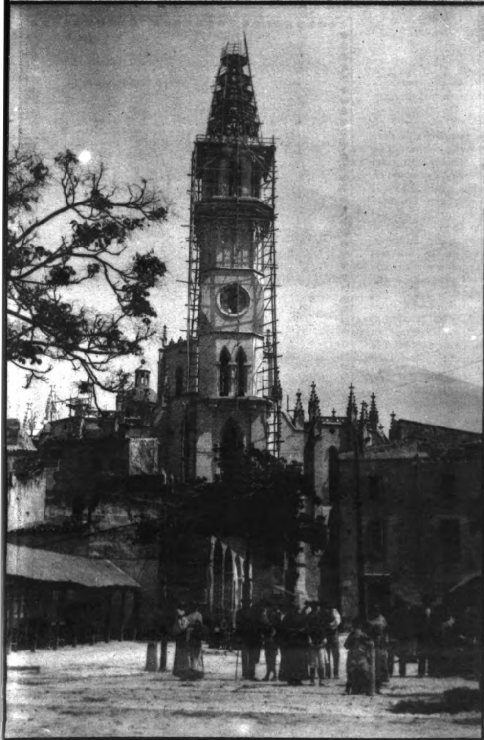
Se está construyendo el pináculo del campanario, y faltan todavía las barandas del primer corredor, las imágenes de sus ángulos, y, por supuesto, la escalera. La foto sería tomada en la primera mitad de la década de los veinte, ya que la Plaza de Abastos todavía no ha sido reformada.
