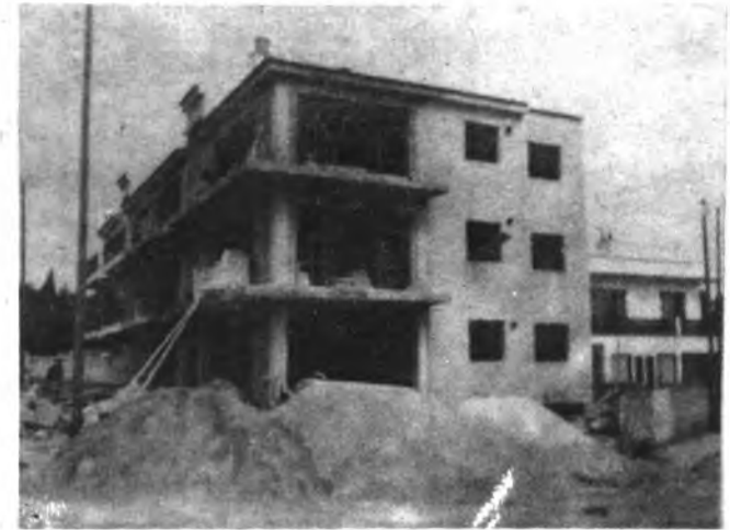
Otro aspecto de las obras que realiza CONS/PORT
