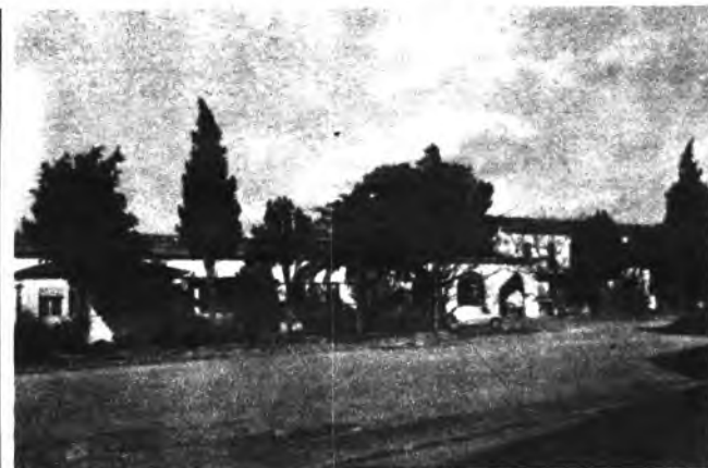
LA PARED DE L'HOSPITAL I CLINICA MUNICIPAL QUE DONAVA A LA CARRETERA DE CIUTAT, JA NO HI ES. L'HAN TOMADA PERQUE FEIA NOSA PER L'AMPLIACIO DE LA CARRETERA, I LA FARAN UNS DOS METRES MES ENDINS.
