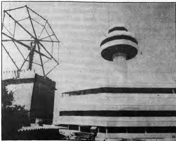
Bella estampa de la Torre de Control de Son San Juan.
