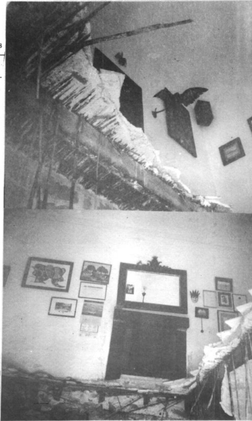
L'enderrocament (Fotos Ferrà)
