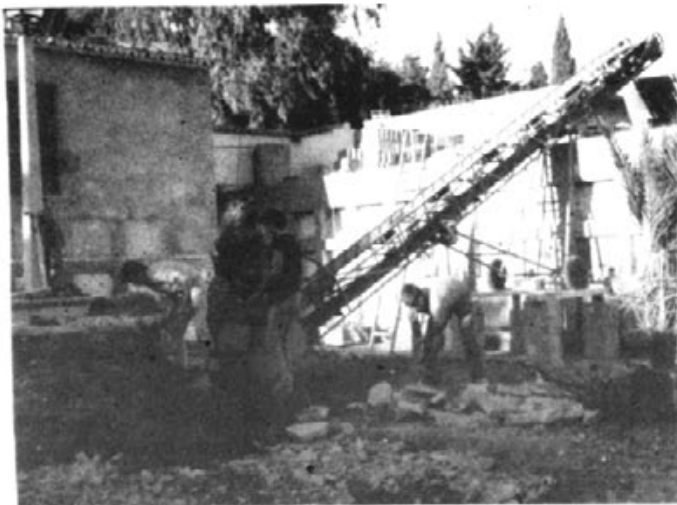
Obres al Cementeri Municipal
