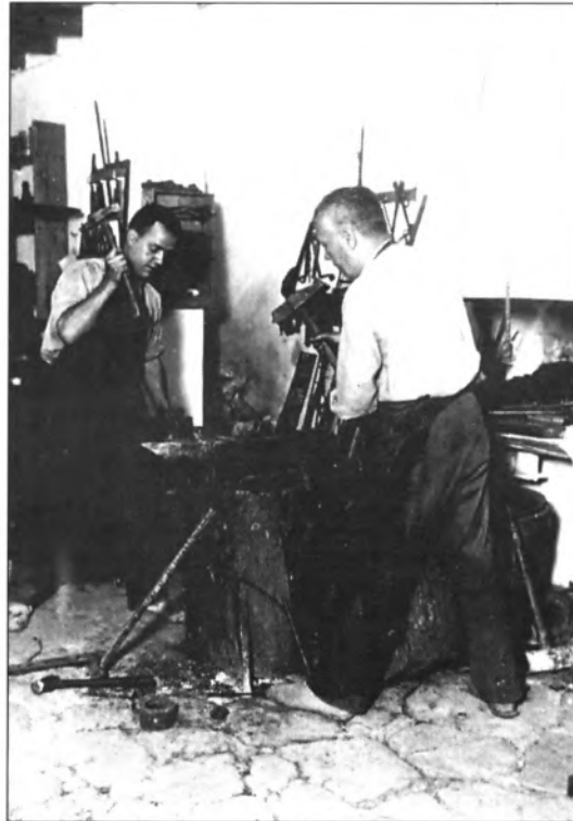
Fotografia 6. El Ferrer de Dalt: Gaspar Pastor, i el seu fill Miquel Pastor martel- lejjant a l'enclusa, darrera ells, la fornal. Gaspar és el padrí de Gaspar Pastor, que encara fa feines de ferrer a l'Eixample, si bé, a més, té un taller mecànic. Arxiu de Joana Lladó.
