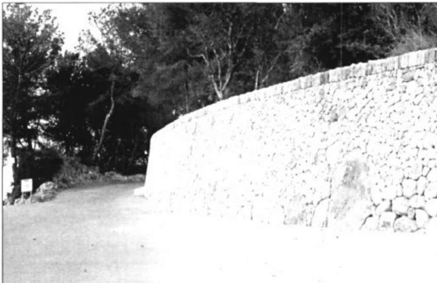
El marge de Consolació és una bona mostra de com cal fer una paret de pedra.
