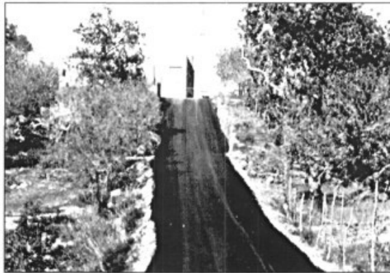
La Conselleria d'Agricultura pagarà el 70% del cost d'asfaltar el camí dels Quatre Vents.
