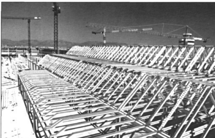
L'edifici que ara es construeix, el de la terminal, estarà preparat per rebre 150.000 clients per dia
