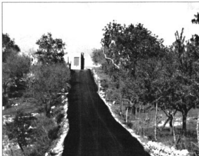
L'asfalt ha arribat al Revellar i als Quatre Vents.
