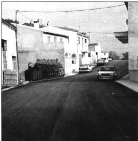
L'asfaltat d'alguns carrers sembla de baixa qualitat. La capa asfàltica ja ha crullat.
