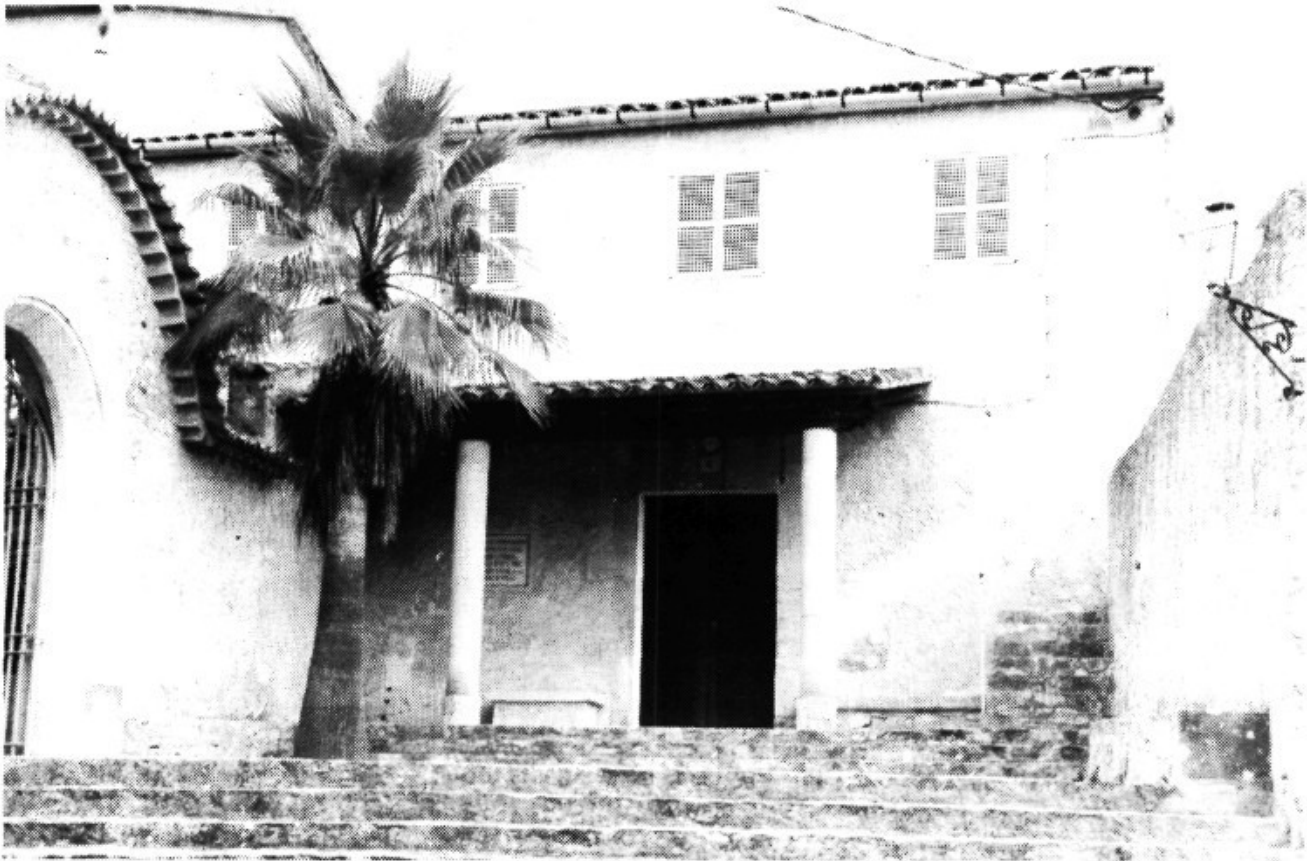
Façana de Cas Donat, renovada amb la restauració del Santuari (1959-1966).
