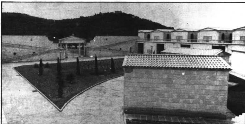
Vista desde el fondo de la ampliación
