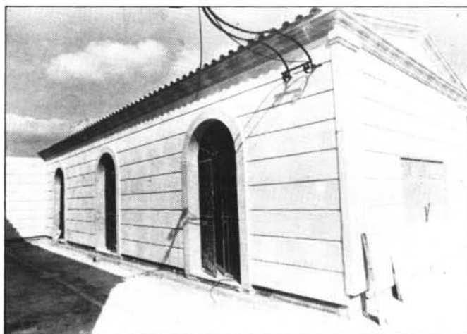
El Mármol y la piedra de Santanyí destacan entre los acabados de la obra
