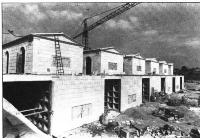
Las obras de ampliación han entrado en su última fase
