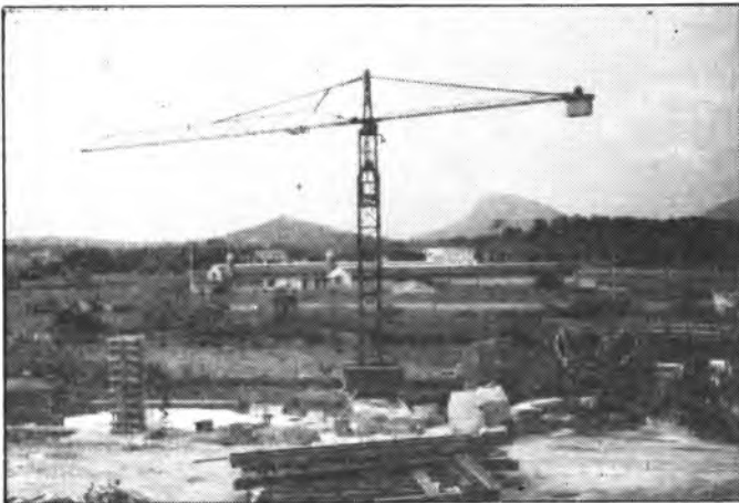
Las obras de la depuradora de Capdepera
