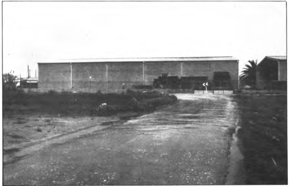
Con la realización de la propuesta comentada, la nave de la izquierda de la imagen, de Maderas S. Riera, deberá ser demolida.
