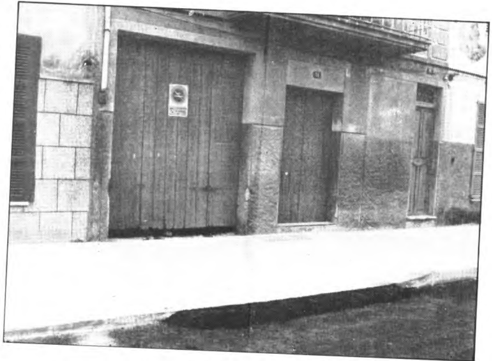
En algunos lugares han aparecido rampas que no estaban en el proyecto
