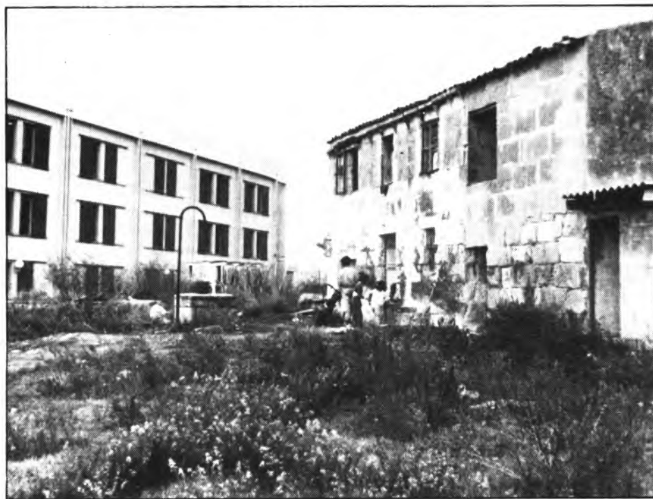
Es evidente que con la construcción del Hospital Comarcal esta casa tendrá que ser demolida
