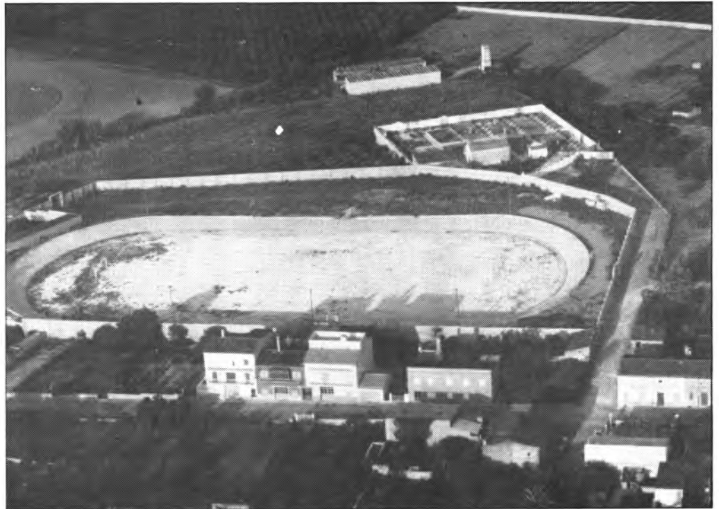
Vista aèria del Poliesportiu i Cementiri Municipal
