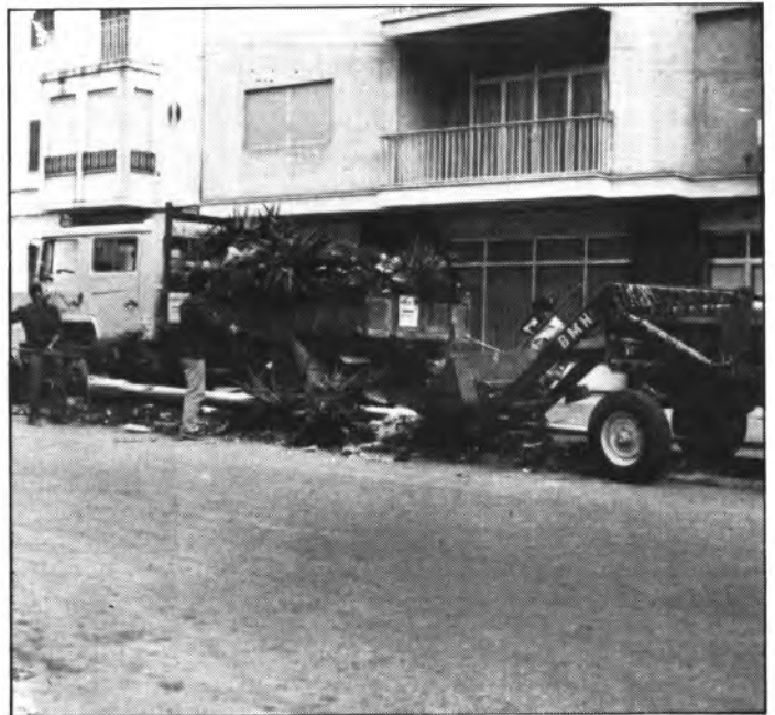
Las Avenidas de Poniente están siendo acondicionadas
