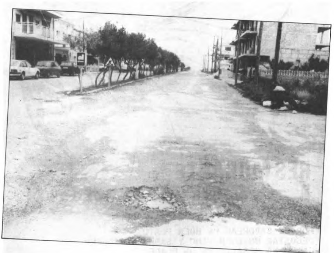
Este bache que puede observarse en primer plano de la imagen, no es sino una leve muestra de los desastres con que se encuentran los conductores unos metros más arriba
