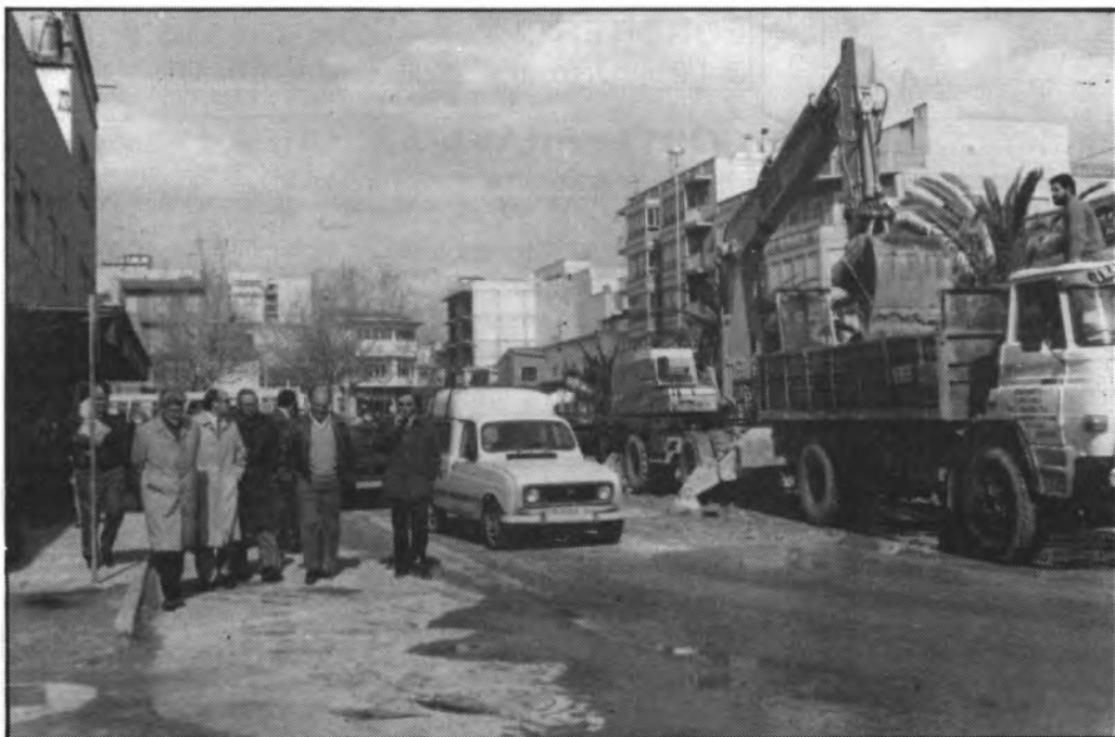
Jeroni Sáiz visitando las obras del Torrent.
