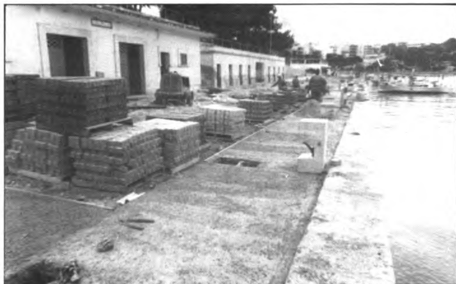
La colocación de adoquines, a buen ritmo.
