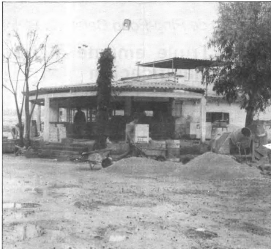
Las obras del Bar del Hipódromo van a suponer una importante mejora de cara a los aficionados. (Fotos: Toni Blau).
