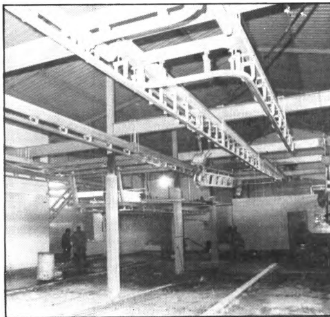
El pasado lunes se estaban terminando las pavimentaciones
