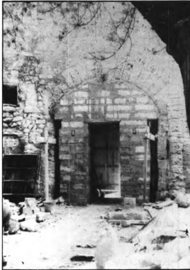
Las obras de restauración de la Torre dels Enegistes no llega al diez por ciento del total de las mismas.
