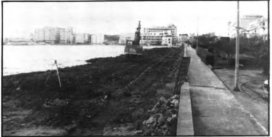
La máquina excavadora en plena faena, el trípode y...
