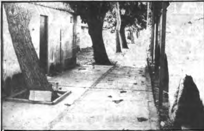
Los pasillos de Na Capellera están siendo objeto de una importante mejora.
