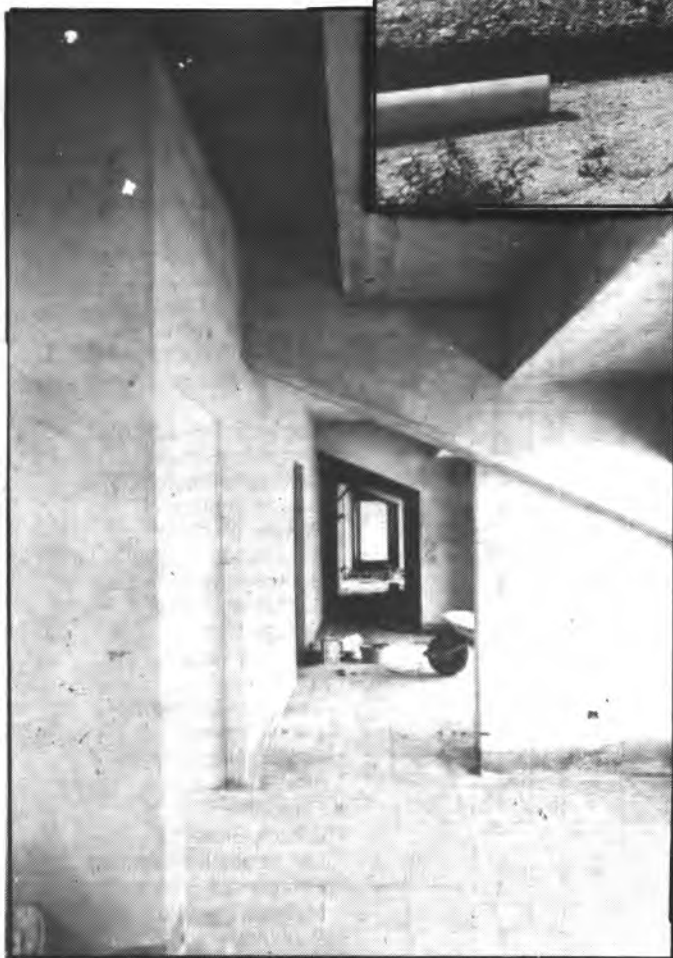
Pasillo adyacente a los vestuarios y dependencias.
