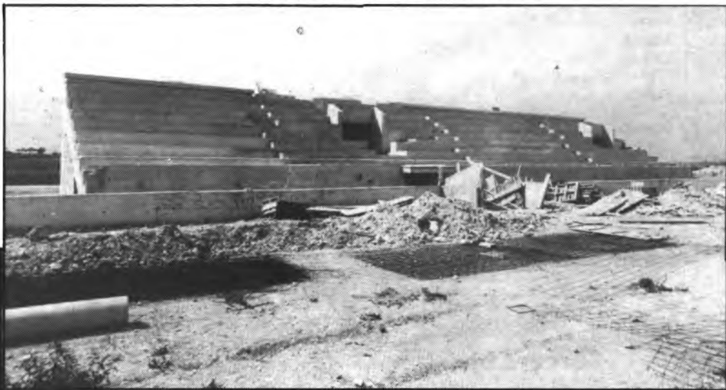
Tramo construido de las tribunas.
