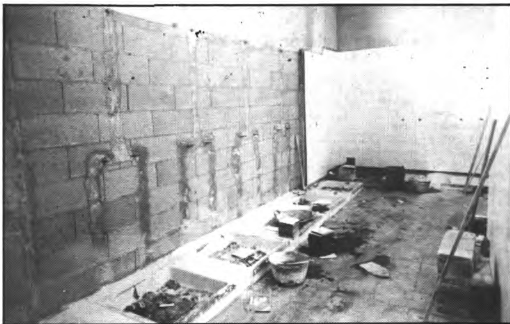
Estado de construcción de uno de los vestuarios.
