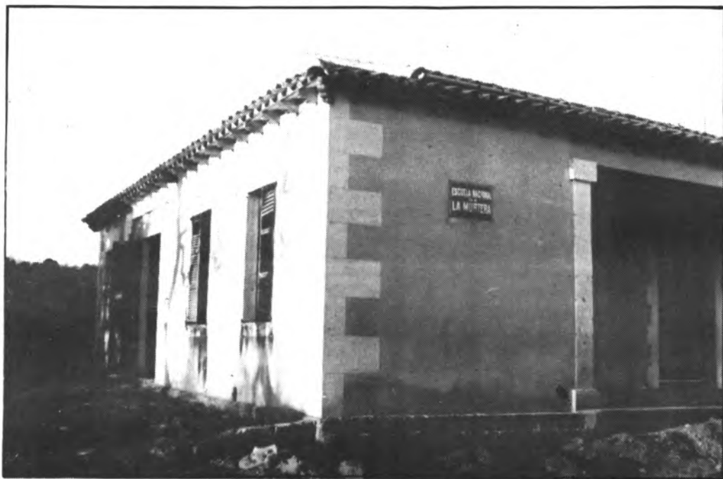
Es farà la instal·lació sanitària de l'Escola de Sa Murtera.
