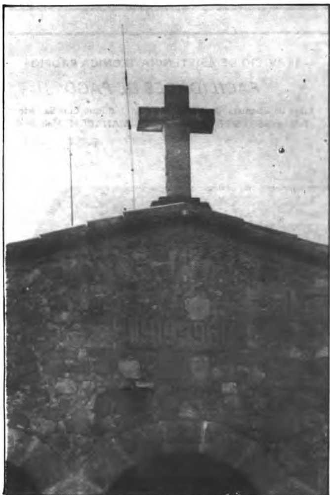
La data com posa la façana, 1919-1960.
