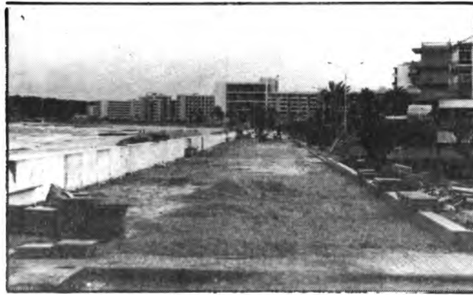
Aspecto que ofrecían las obras del Paseo Marítimo captadas por nuestro fotógrafo Forteza Hnos.
