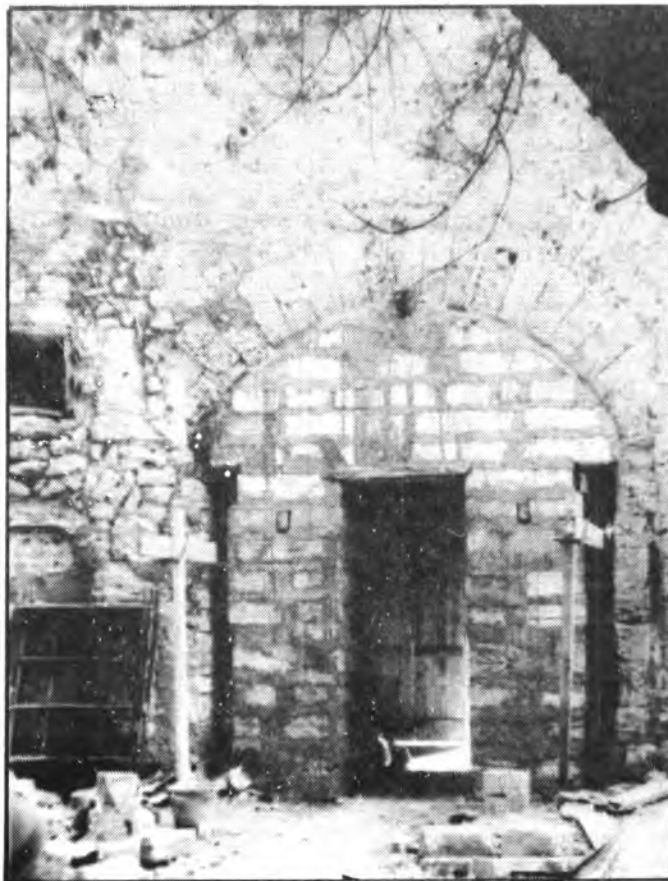
S'estan restaurant les arcades de les portes.
