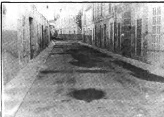
Les clapes d'asfalt no embelleixen en absolut els carrers, però fan que siguin transitables mentre estan a l'espera de què siguin asfaltats de tot.
