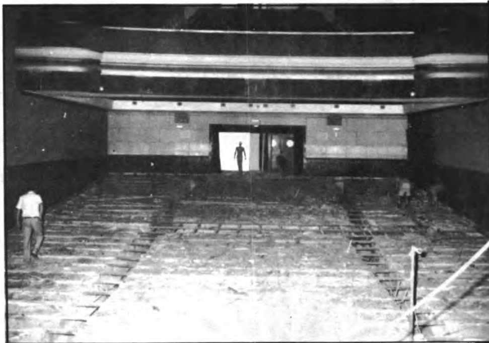
L'interior del local, desmantelat
