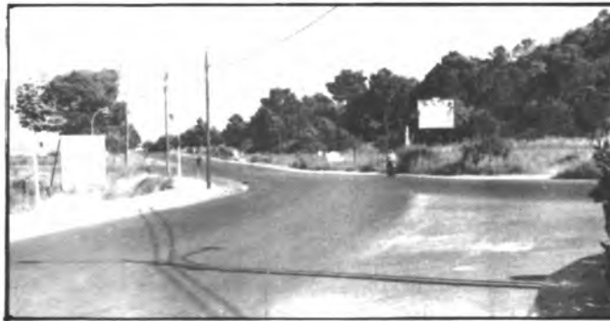
La foto de M. Llodrá muestra el perfecto estado del firme pero la falta total de señalización en el mismo.
