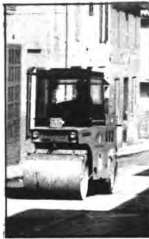
La Tercera Fase contempla l'asfaltat de setanta-sis carrers
