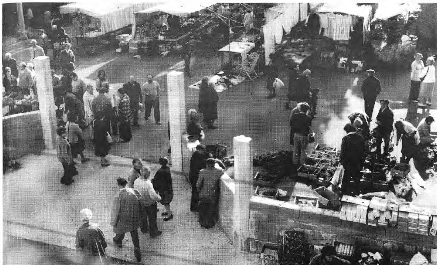
Una vez finalizadas las obras , el Mercado de Son Servera se erigirá en uno de los orgullos de la villa.
