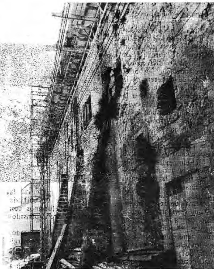
La restauración de la cornisa de la fachada del Claustro está en su mitad.
