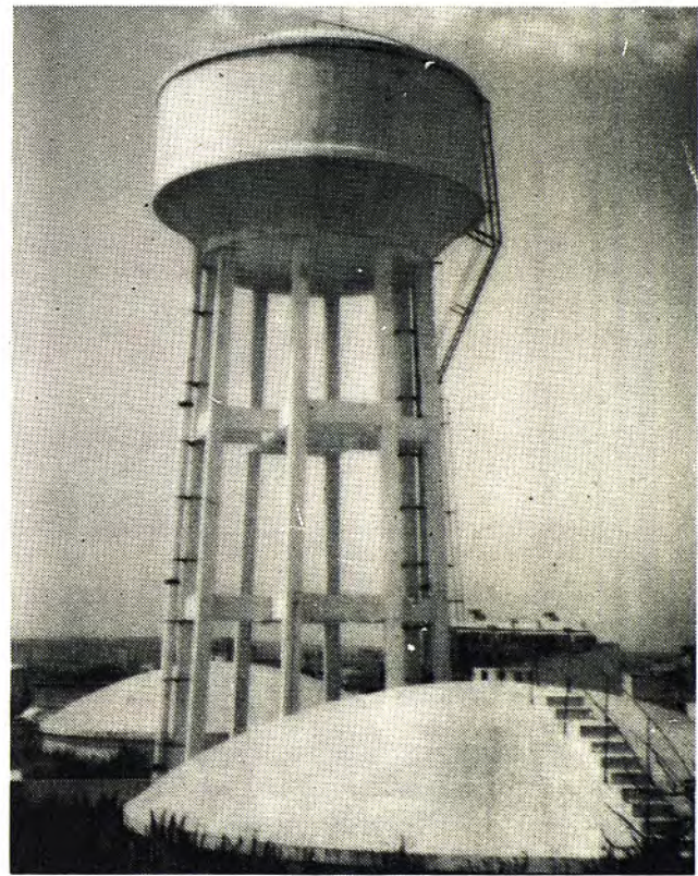
Estación impulsora de la instalación de abastecimiento de aguas.
