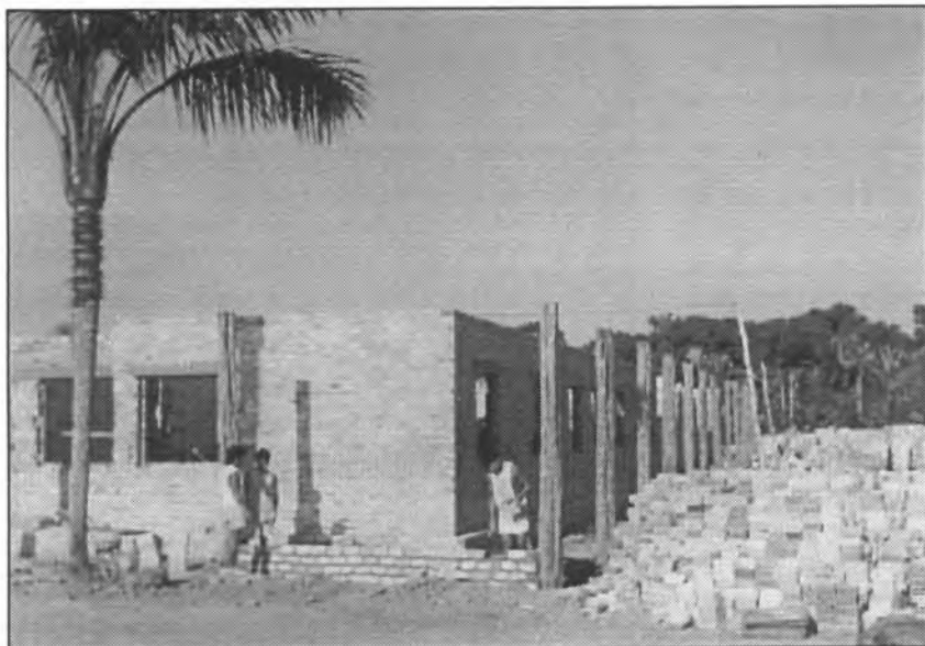
Hospital en construcció
