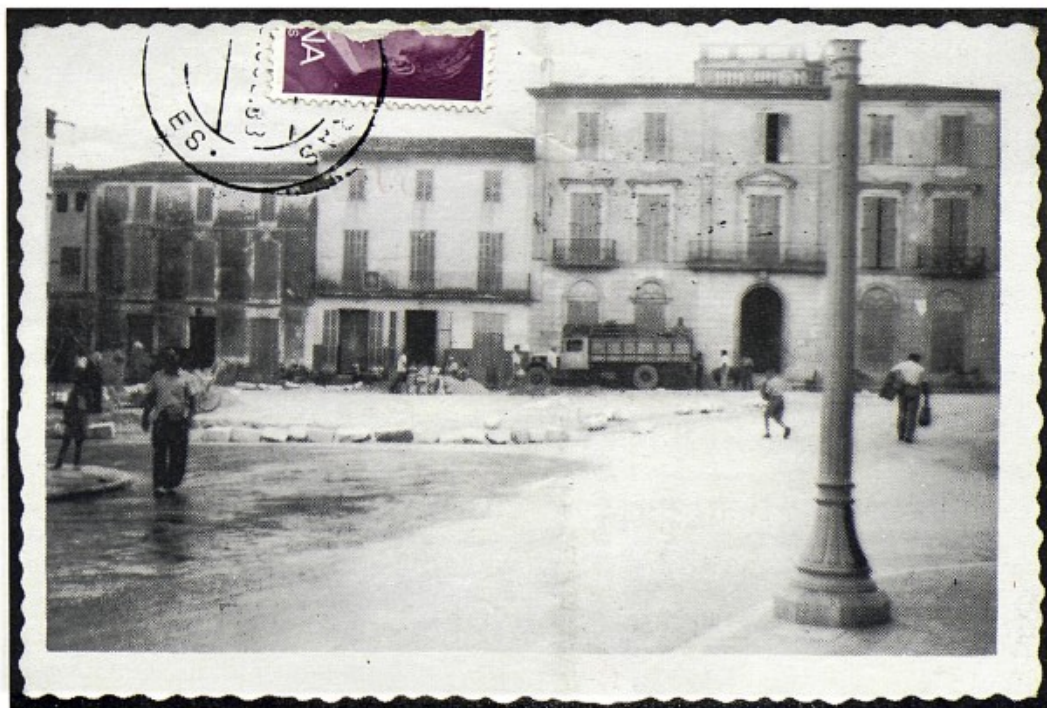
Sa Plaça en construcció (26-juliol-1.953)
